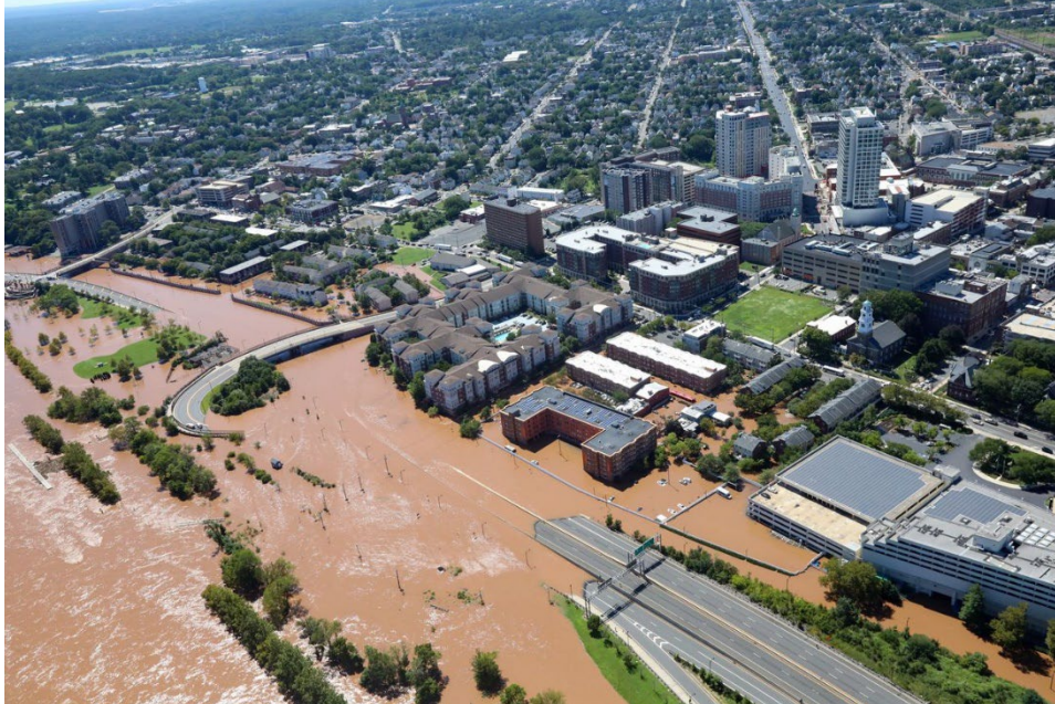
Fig. 16: Ruta 18 en New Brunswick, Rutgers University, sumergida bajo agua el jueves 2 de septiembre de 2021 tras la crecida del río, causada por la tormenta tropical Ida.
