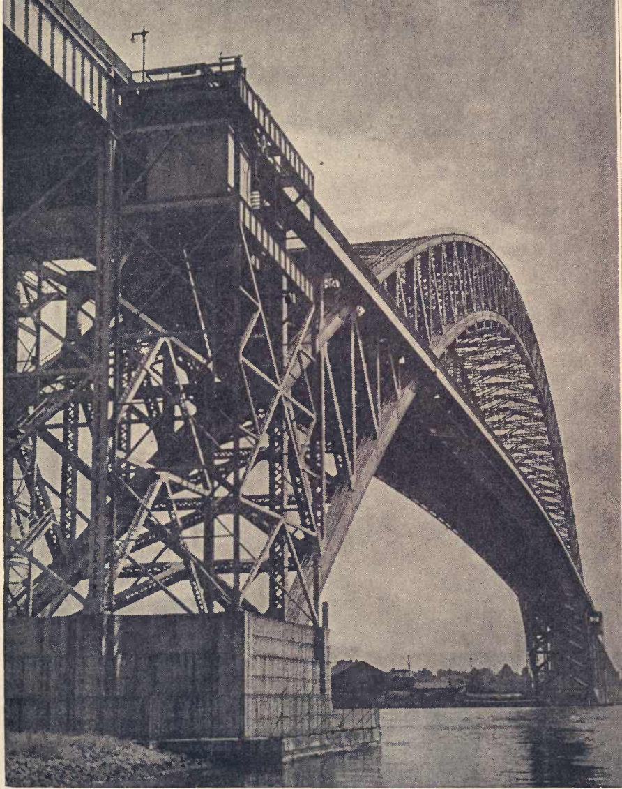
BAYONNE BRIDGE OVER KILL VAN KULL
